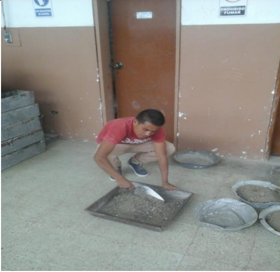
Realizando la mezcla
