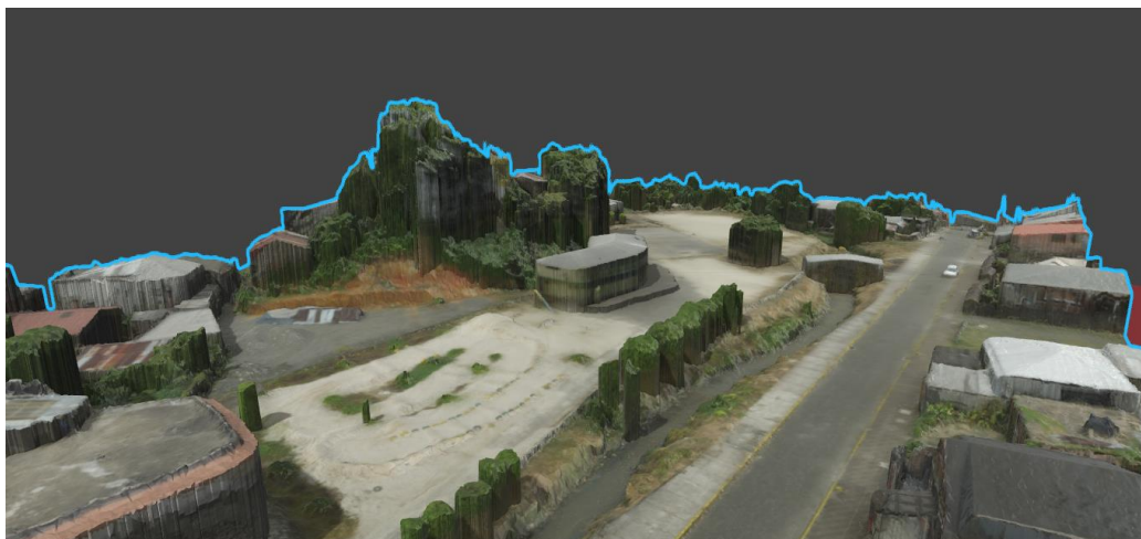
Ilustración 87: Estado actual del complejo amazonas en 3D / vista 1 Fuente: FanAir – dji Phantom
