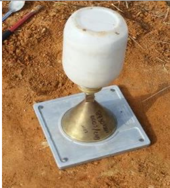
Colocación de Arena de Ottawa en agujero realizado
