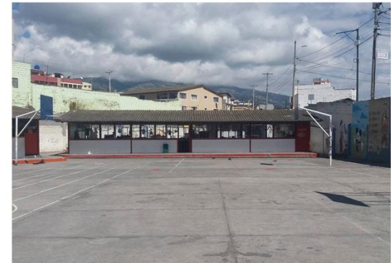
PATIO Y FACHADA DEL AULA
