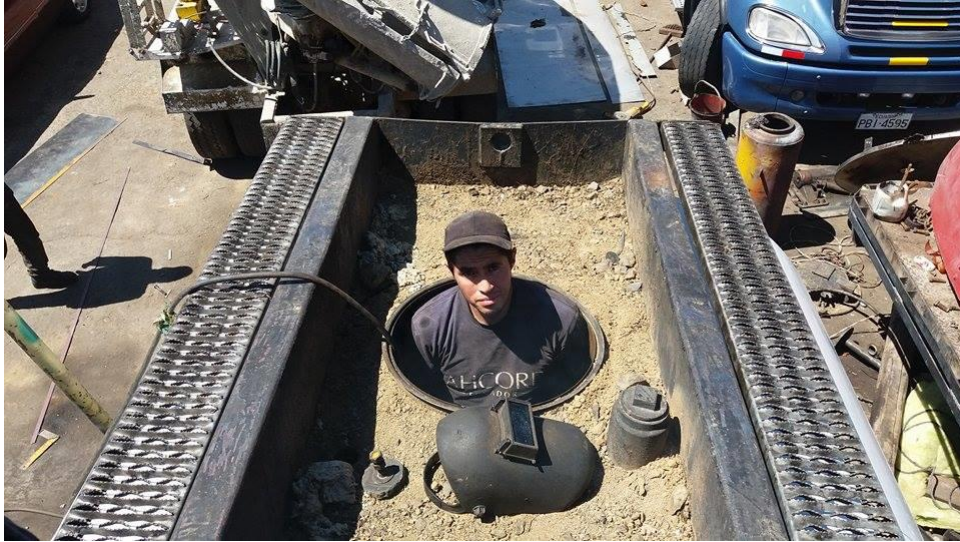
Figura No. 25. Ingreso del Trabajador al autotanque. Fuente: Empresa.
