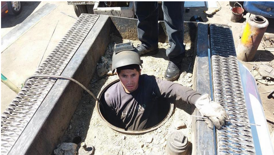
Trabajador ingresando al autotanque.
