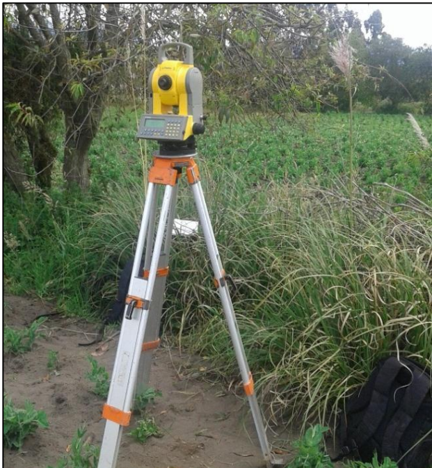
Nivelación del equipo Topografico
