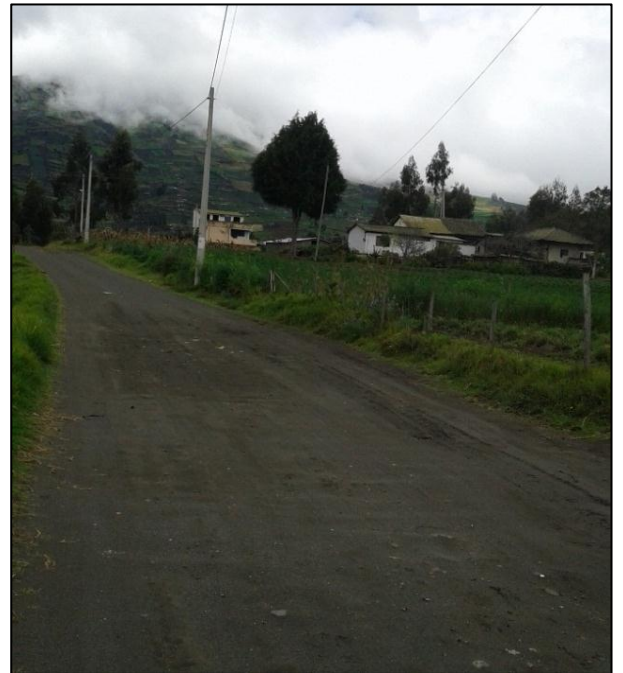
Inicio de la Calle C del Proyecto
