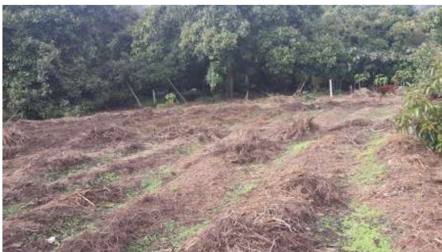
FIGURA 1. LIMPIEZA DE TERRENO
