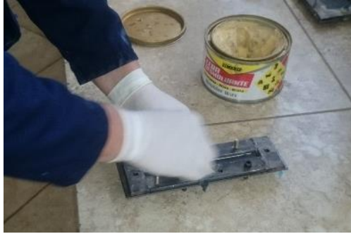
Figura 3.38.- Aplicación de cera desmoldante Fuente. Autor
