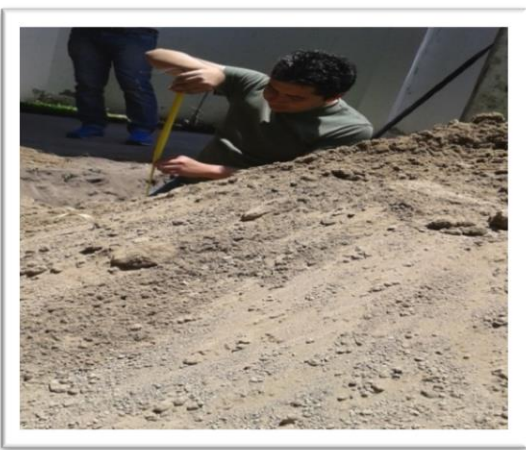
Medición de calicata P2
