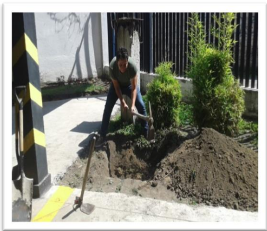
Excavación de calicatas P2
