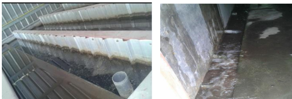
Fig. 51 Limpieza de tanques y colocación de pastillas de cloro.
