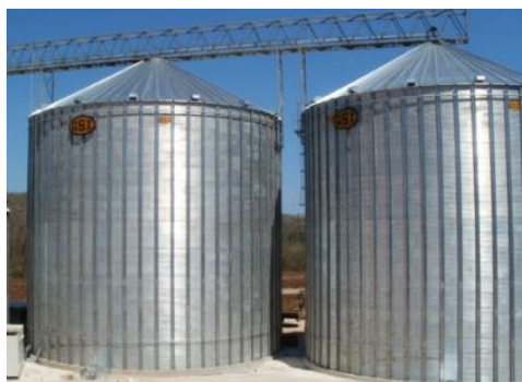
Fig. 6 Silos de almacenamiento de materia prima.
