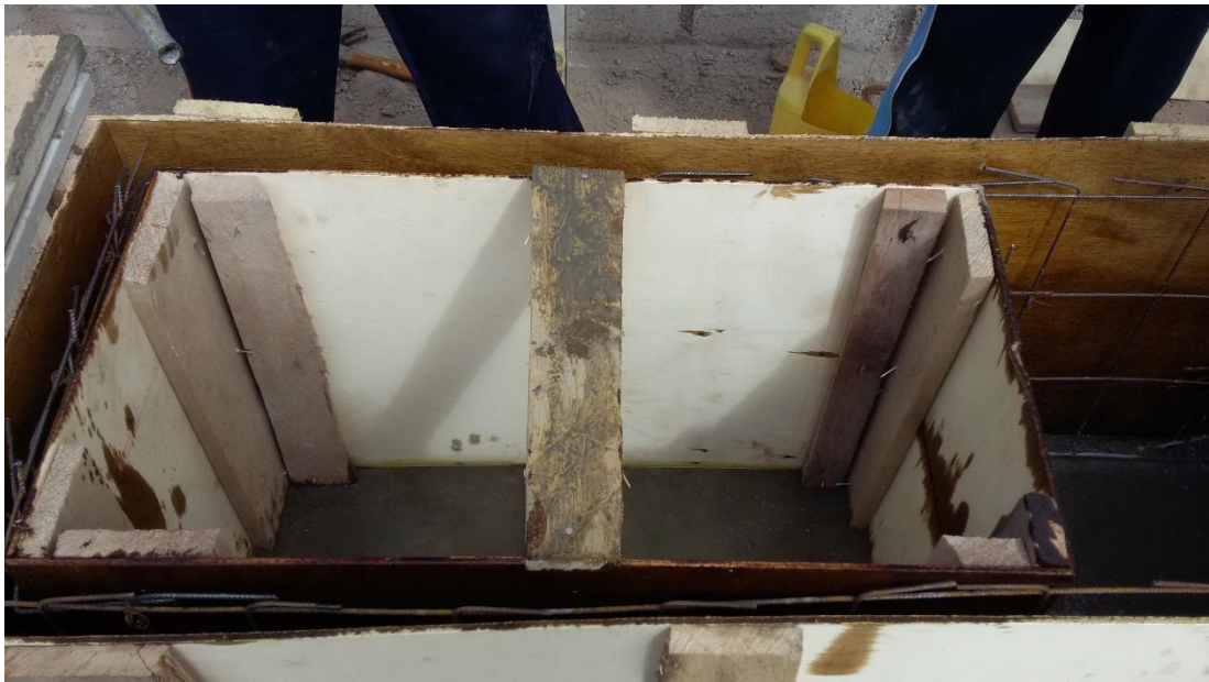
Foto N° 5.- Hormigonado de Tanque Séptico.
