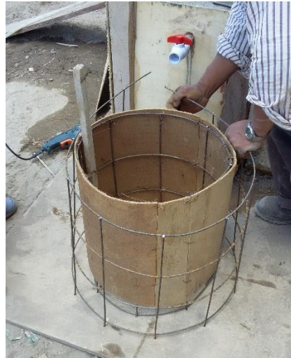
Foto N° 3,4.- Encofrado y armado de Tanque Séptico y Filtro Biológico respectivamente.
