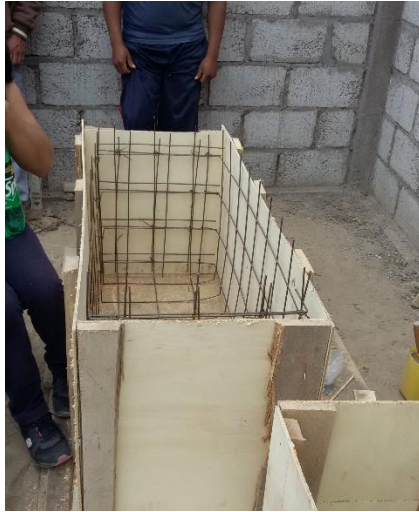
Foto N° 3,4.- Encofrado y armado de Tanque Séptico y Filtro Biológico respectivamente.
