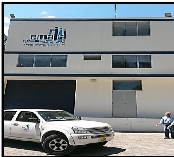
Ilustración G-9 Instalaciones de la Envasadora de Agua de la EP- EMAPA-A: Planta Tilulúm
