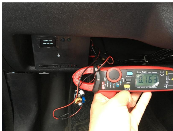
Figura 4.40 Medición del sistema con Pinza Amperimétrica
