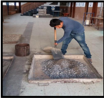
Fotografía 13.- Mezcla de los agregados grueso y fino.
