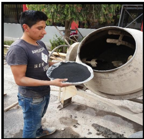
Fotografía 41.- Colocación de la ceniza en la concreteira después de los agregados.
