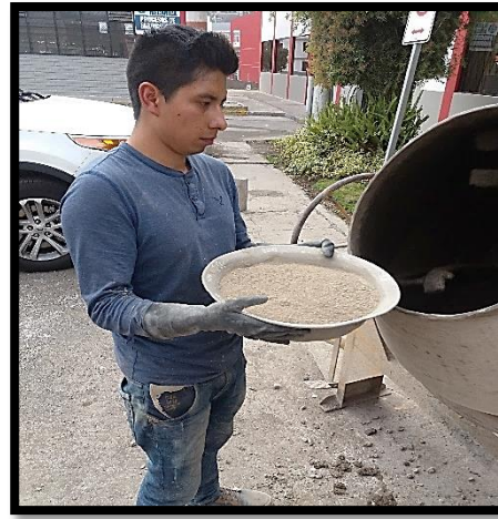
Fotografía 46.- Colocación de microsilice en la concretera después de los agregados.
