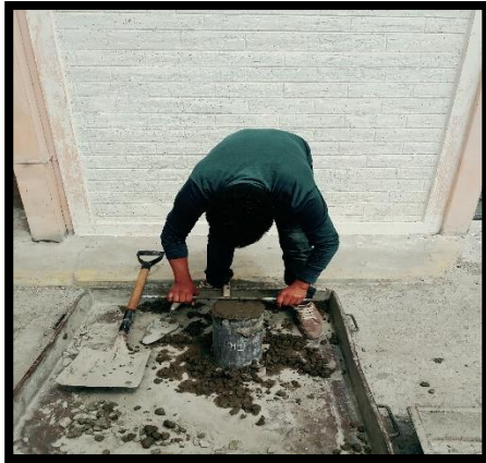
Fotografía 31.- Enrazado de la probeta de hormigón f'c = 240 \text{ kg/cm}^2 .
