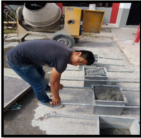
Fotografía 27.- Dosificación al peso de los agregados en parihuelas.
