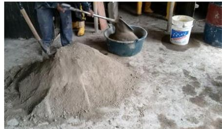
Mezcla de agregados arena-cemento.
