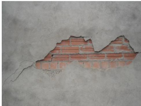
***Imagen 14. Falla de adherencia por mortero,***
