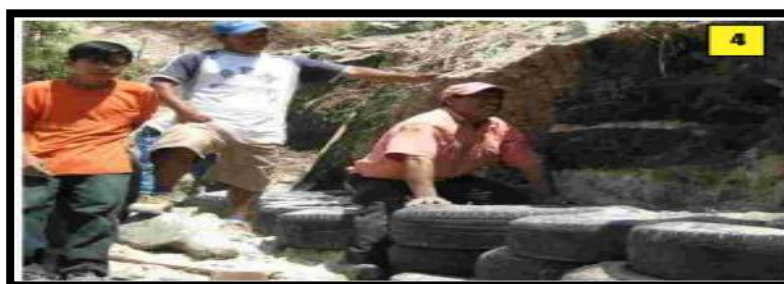
Gráfico N° 28 Continuidad en hileras de llantas
