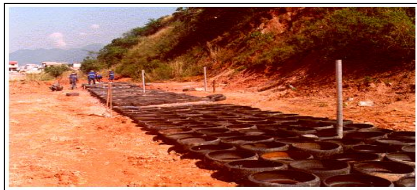
Gráfico N° 23 Inicio de la construcción del muro
