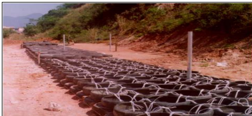
Gráfico N° 24 Atado de los neumáticos del muro
