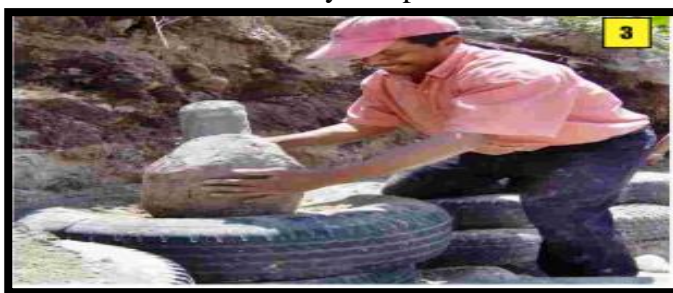
Gráfico N° 27 Relleno y compactación de llantas
