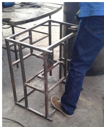
Figura anexo. 32 Esmerilado de la estructura completa
