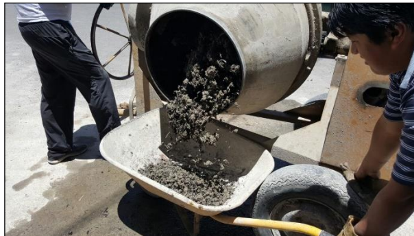
Fotografía N° 17. Mezcla de Hormigón
