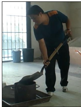
Fotografía N° 10. Mezcla del Agregado
