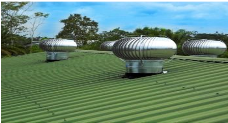
Figura 43: Ventiladores eólicos tipo cebolla
