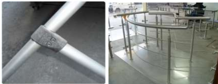
Figura. 2.1 Pasamanos fabricados de aluminio [11].
