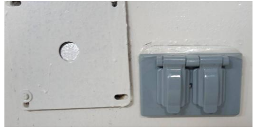
DESPUÉS CON TAPAS PARA TOMA CORRIENTES
