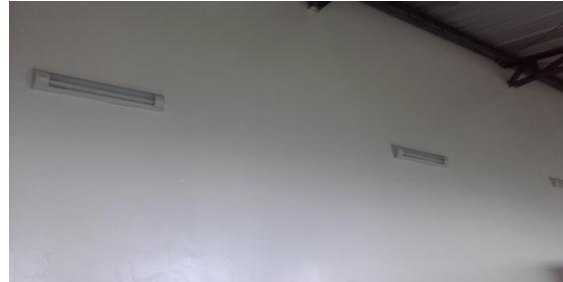
DESPUÉS CON PINTURA EPOXICA
