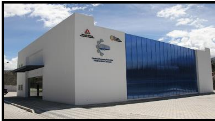
Figura 5 Instalaciones Centro de Fomento Productivo Metalmecánico Carrocero [43].
