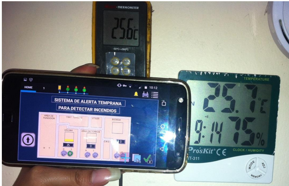
Figura 4. 41: Sensor de temperatura funcionando adecuadamente en el Administrativo
