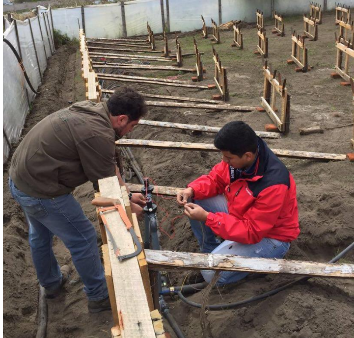
Figura 20. Ubicación de los tableros externos, que soportarán la carga del cultivo hidropónico, cada uno de los tableros deben estar aislados del suelo mediante ladrillos con el objeto de no permitir que la madera absorba la humedad, de esta forma se logra mayor vida útil de la estructura.
