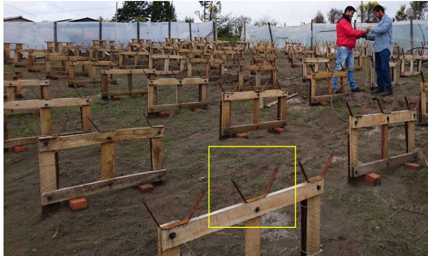
Figura 22. Las varillas cara de vaca ayudan a sujetar y dar forma a la canaleta del cultivo hidropónico
