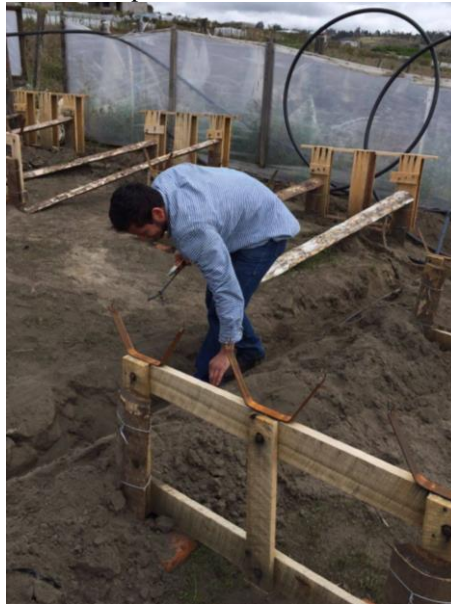
Figura 23. Ubicación los alambres laterales y de fondo para darle forma a los canales a través del plástico de polietileno en el cual se instala el sistema de riego a goteo y posteriormente se rellenarán estos canales con sustrato (fibra de coco).
