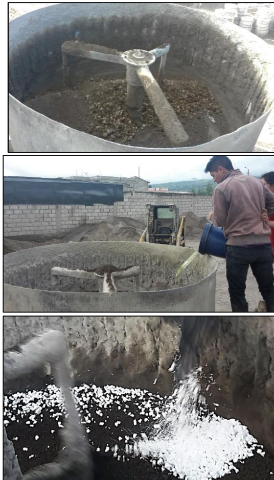
Gráfico 40. Preparación de la mezcla con poliestireno expandido.
