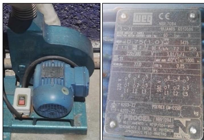
Figura 52 Especificaciones Técnicas del Motor del Extractor Centrífugo. Elaborado por: Investigador
