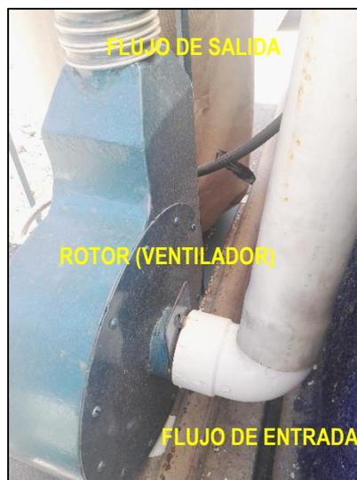
Figura 51 Partes constitutivas del extractor centrífugo. Elaborado por investigador.
