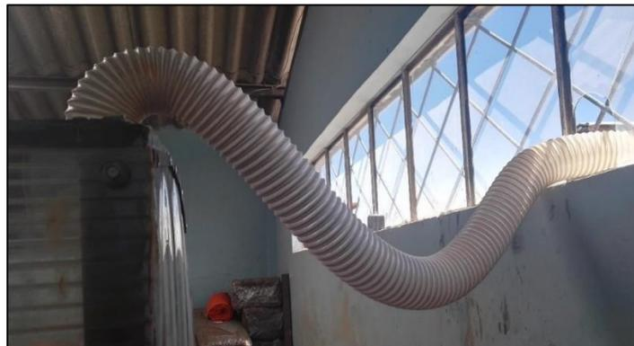
*Figura 53* Ducto de conducción de polvo químico extraído. Elaborado por investigador.
