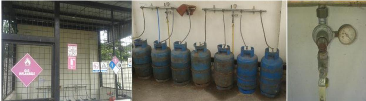
Figura 27. a) Concentrador de GLP. b) Manómetro y válvula de primera etapa. Fuente: Investigador.
