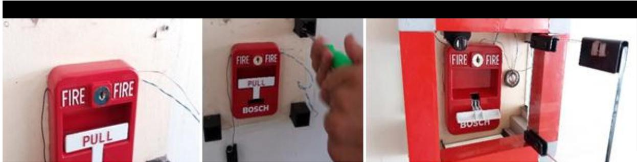
Figura 68. Cableado de pulsadores en los cajetines y estaciones manuales. Fuente: Investigador.
