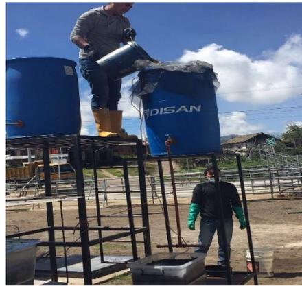
**Imagen 26.** Cernido de agua residual para obtener agua sin restos del faenamiento y evitar taponamiento en la tubería PVC.
