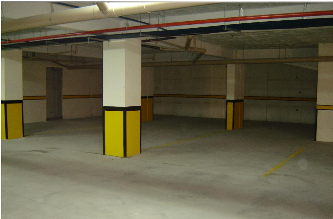
Figura 4.125. Vista columnas en subsuelo.
