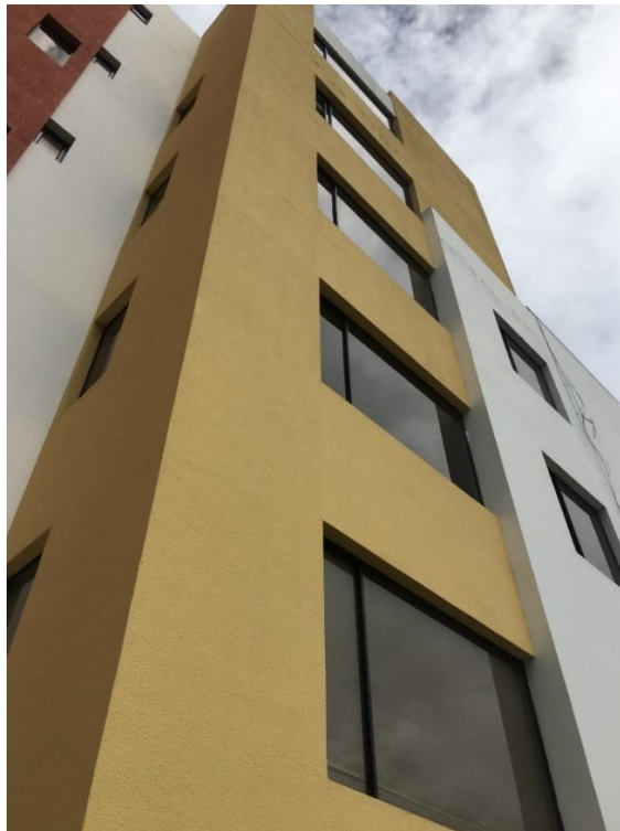
Figura 4.119. Vista fachada lateral derecha.
