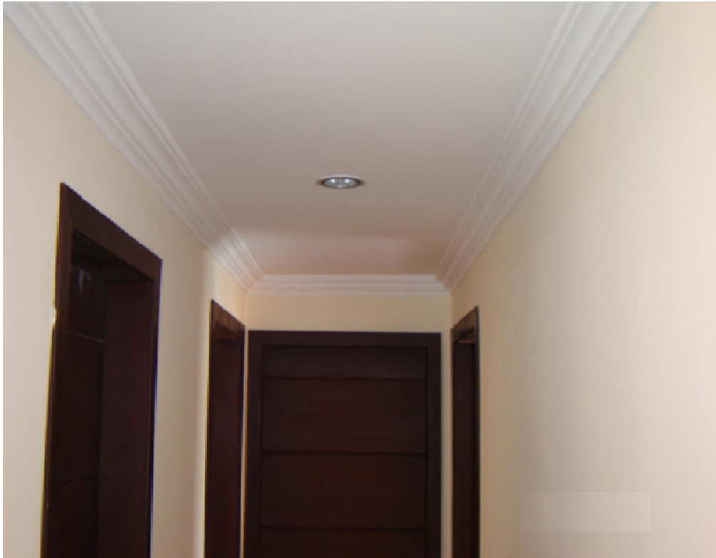
Figura 4.128. Vista en pasillo.
