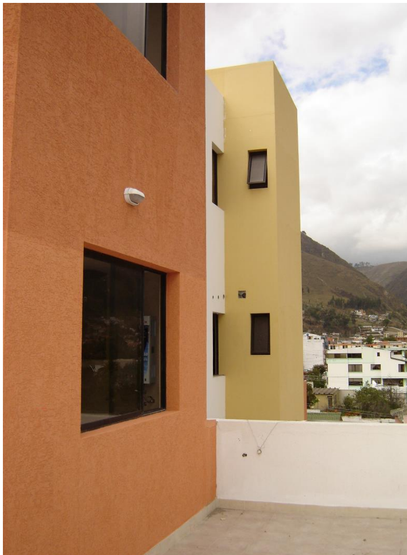
Figura 4.121. Vista parcial fachada posterior.
