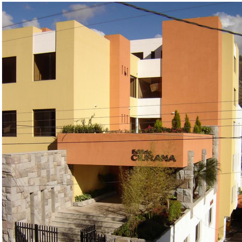
Figura 4.117. Vista fachada frontal.
