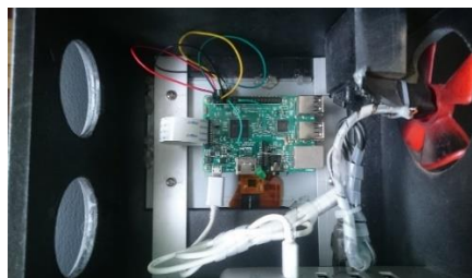
Figura A.5. Parte interna del sistema SERSETRA
