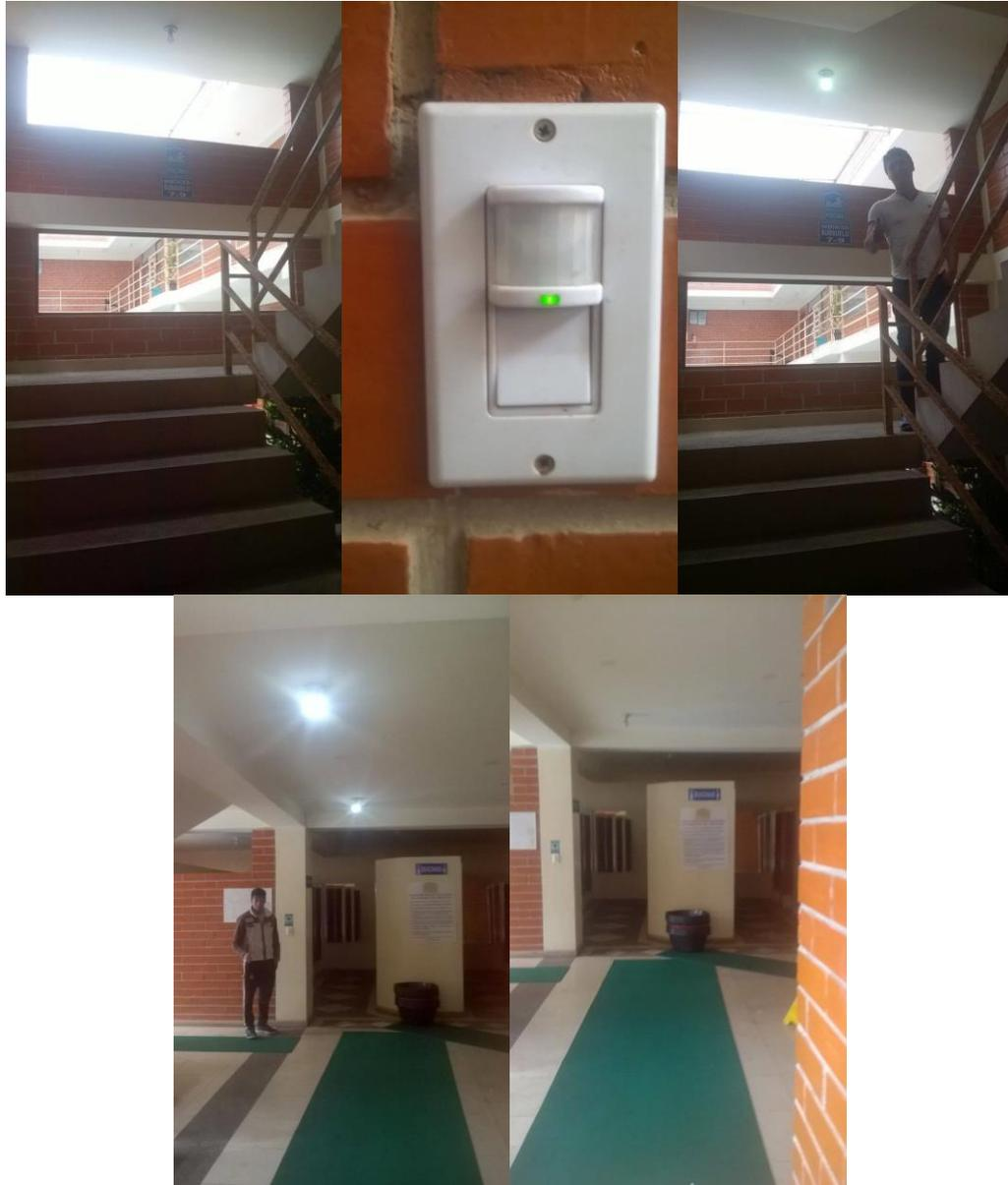
Figura 90: Funcionamiento de Sensores de Movimiento para Iluminación automática
