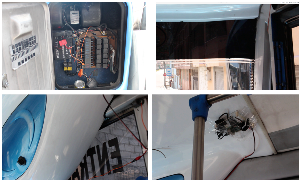
Figura 48. Alimentación y cableado de energía
