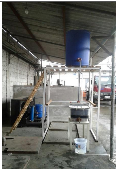
5. Elaboración e instalación del Filtro
