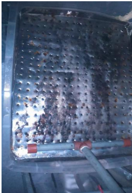
Imagen 11.- Acumulación de Sedimentos en la Placa Superior.
