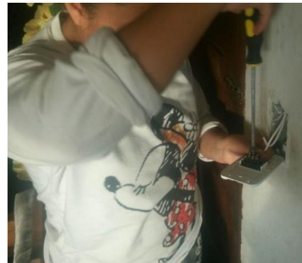
Figura D6. Instalación de luces
