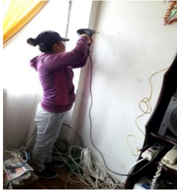
Figura D8. Colocación de la caja central
