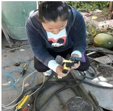
Figura D3. Instalación y pruebas sensor de flujo y aspersor
