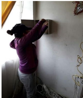
Figura D9. Colocación de la caja central
