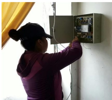
Figura D10. Colocación de la caja central
