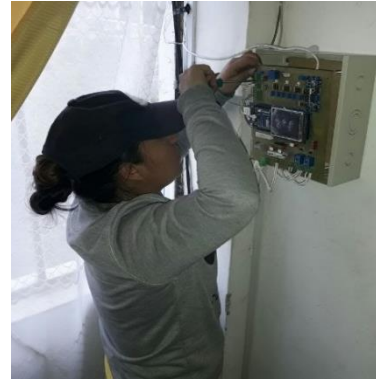
Figura D11. Sujeción de cables a la caja
