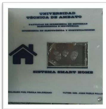
Figura 4.19 Colocación de placa para protección del circuito del sistema
