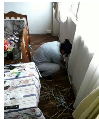
Figura D7. Instalación de luces y puesta de canaletas
