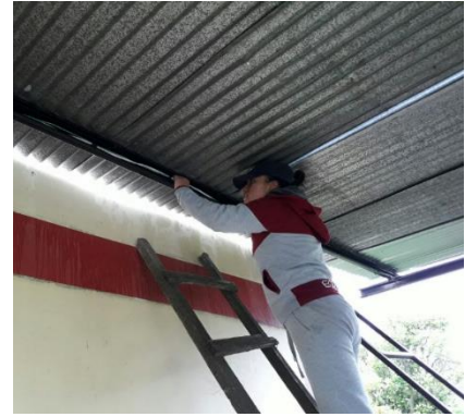
Figura D5. Tendido de cables
