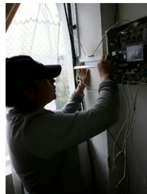
Figura D12. Colocación de canaletas
