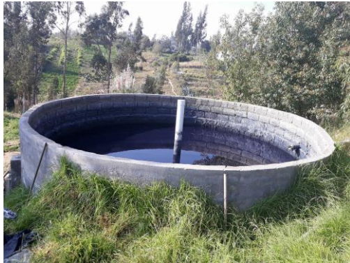
Foto 7. Pozo de descarga del efluente.
