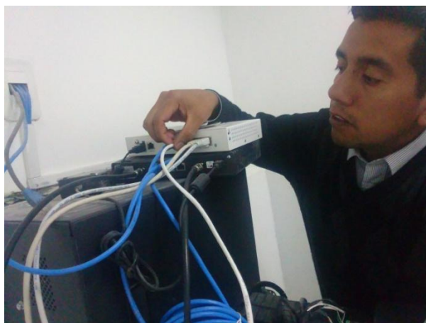
Figura 38. Instalación del router en el ATM
