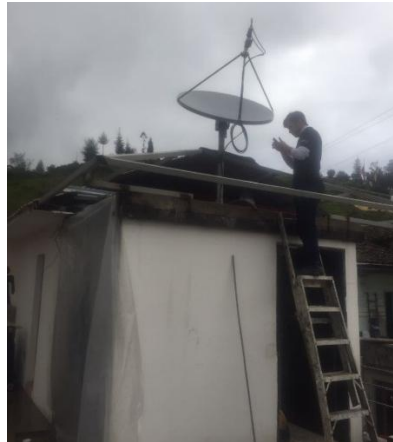
Figura 36. Instalación de la Antena Satelital (VSAT)
