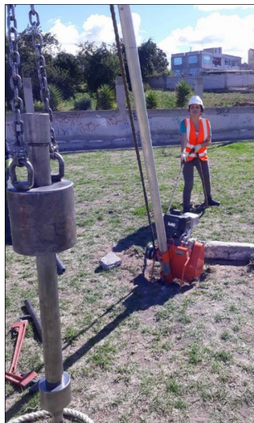
Fotografía 5. Hincado del Martinete
