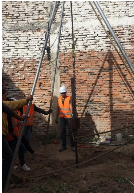
Fotografía 4. Hincado de martinete
