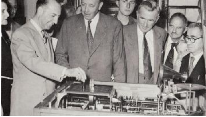
El Ajedrecista, una especie de máquina automática que simula el final de una partida de ajedrez.
