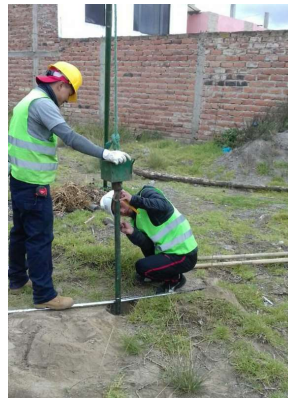
Fotografía 2: Medición de Perforación a cada 15cm
