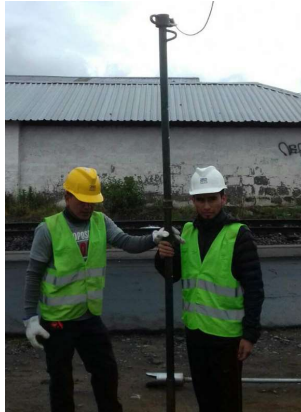
Fotografía 1: Realizando el Ensayo SPT
