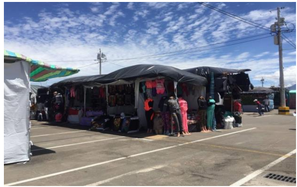
Imagen 108. Recubrimiento con plástico de los stands del municipio por filtración de agua; Feria de Finados 2017
