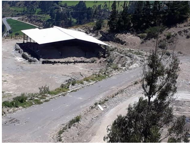
Figura E1: Zona de depósito de desechos hospitalarios del Relleno Sanitario - GADM Riobamba
