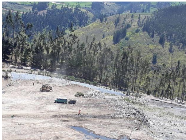
Figura E2: Zona de depósito de desechos comunes del Relleno Sanitario - GADM Riobamba
