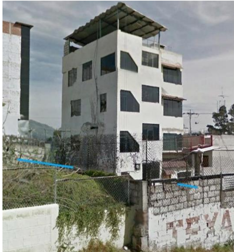
Fotografía 20. Edificación de 5 pisos
