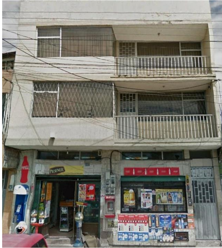
Fotografía 19. Edificación de 3 pisos
