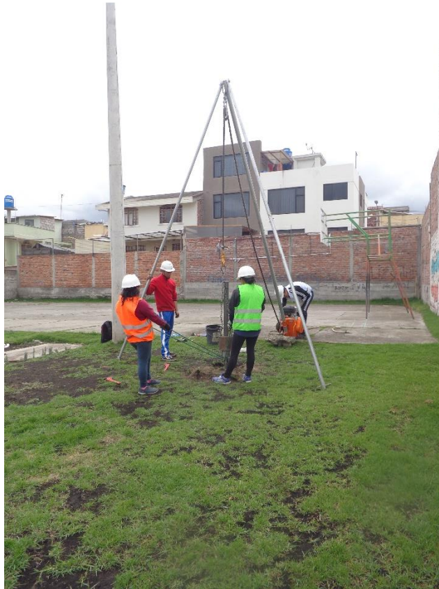
Fotografía 5.- Hincado del martinete
