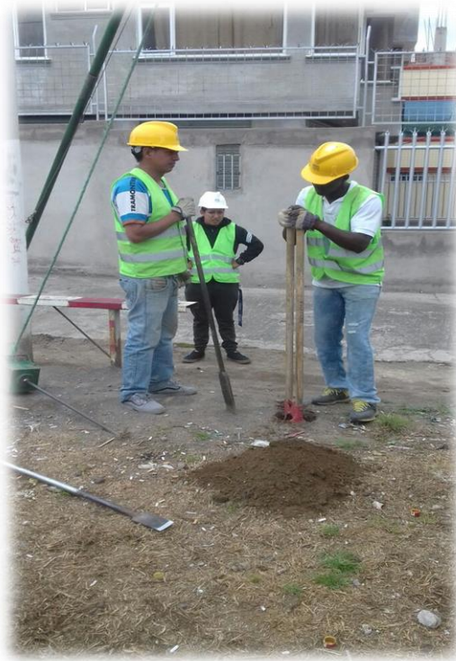
Fotografía 1. Excavación de suelo vegetal
