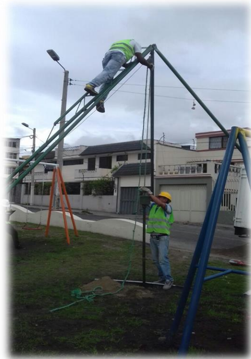
Fotografía 2. Colocación del martinete
