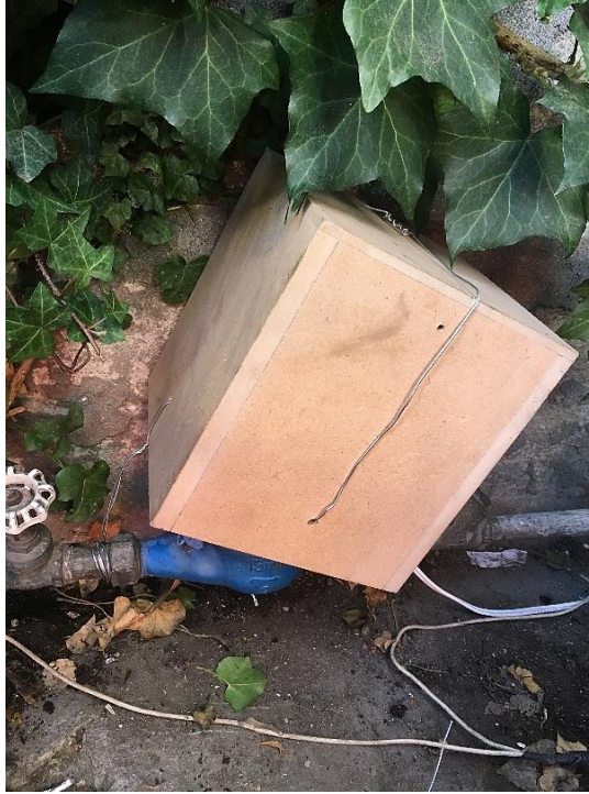
Fotografía 7. Instalación del equipo usado para realizar la medición horaria en el medidor seleccionado
