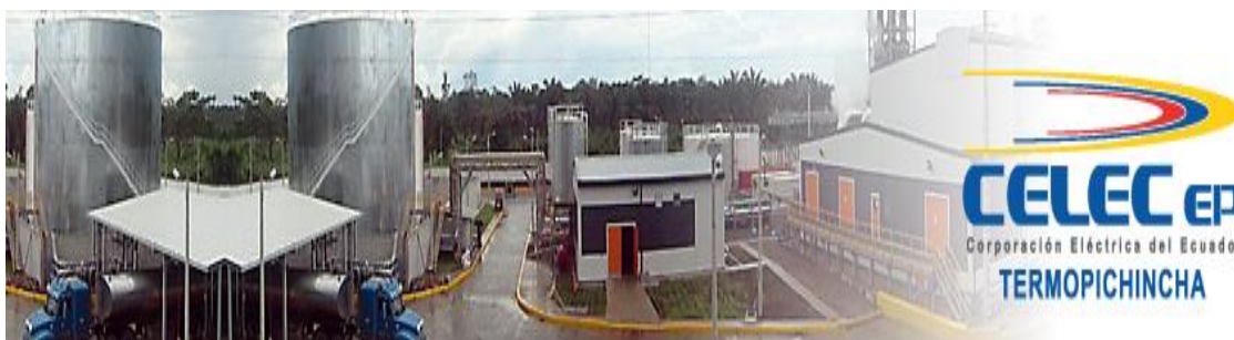
Figura 5 Imagen general de TERMOPICHINCHA
