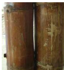
Imágen 46: Para fijar 2 o más bambúes alineados Fuente: (Ubidia, 2015)
