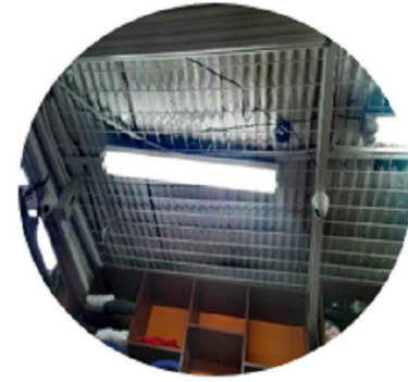
Malla metálica electrosoldada, techo de zinc, iluminación general.
